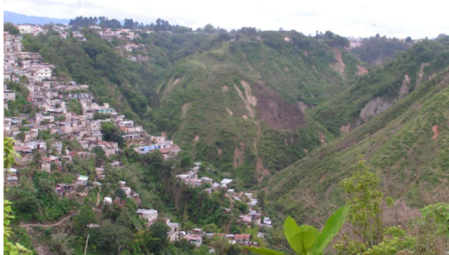
Figura 1. Suburbio de la ciudad capital de Guatemala, en marzo de 2015. Se observan al fondo áreas de pendiente fuerte y cicatrices de desprendimiento superficial de suelos. Foto: Nelson Arroyo.
