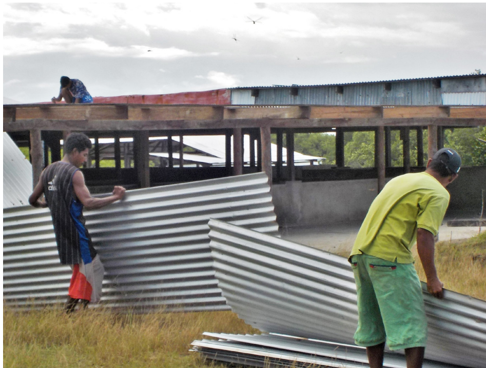
Figura 4: Deconstrucción de la planta in Tuapi en noviembre de 2017.
