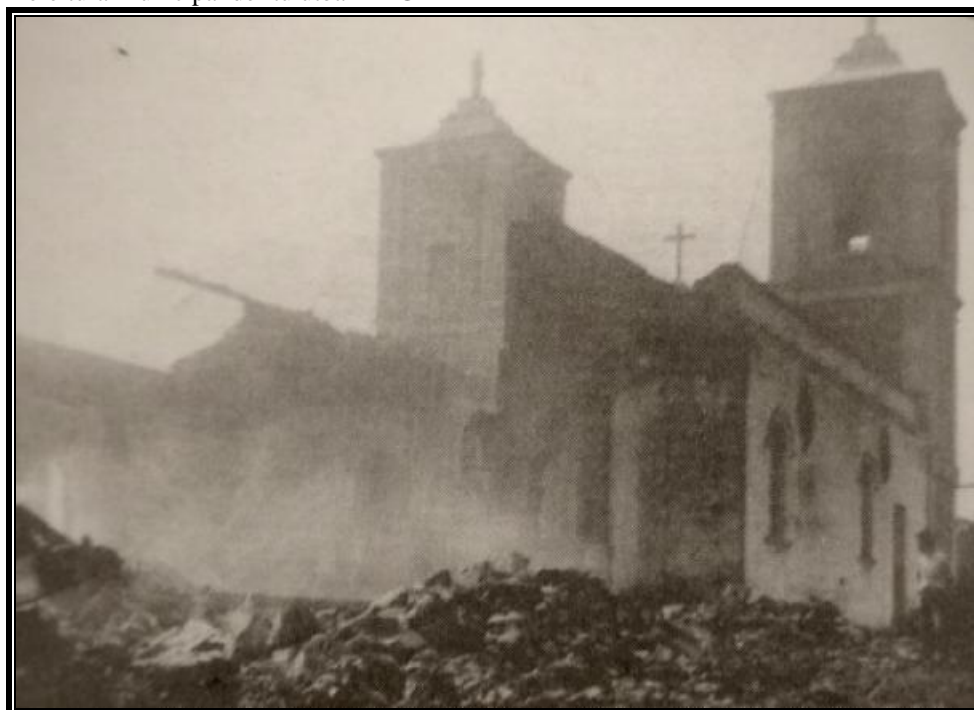
Figura 04: Incêndio na igreja matriz
