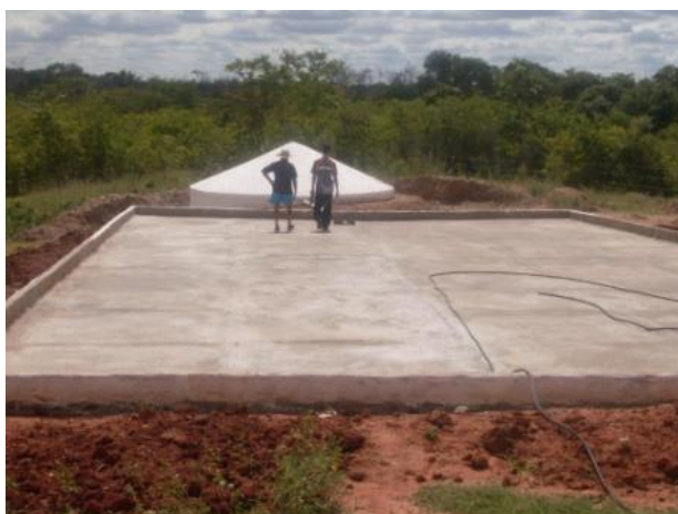
Foto 4: Fase de conclusão da Cisterna Calçada no Sítio Vaca Morta, Cajazeiras, 2010
