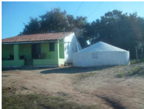
Foto 2: Cisterna de placa no Sítio Patamuté. Cajazeiras, 2010.
