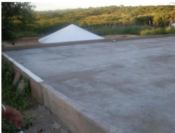
Foto 3: Cisterna Calçada no Sítio Patamutê, Cajazeiras, 2010
