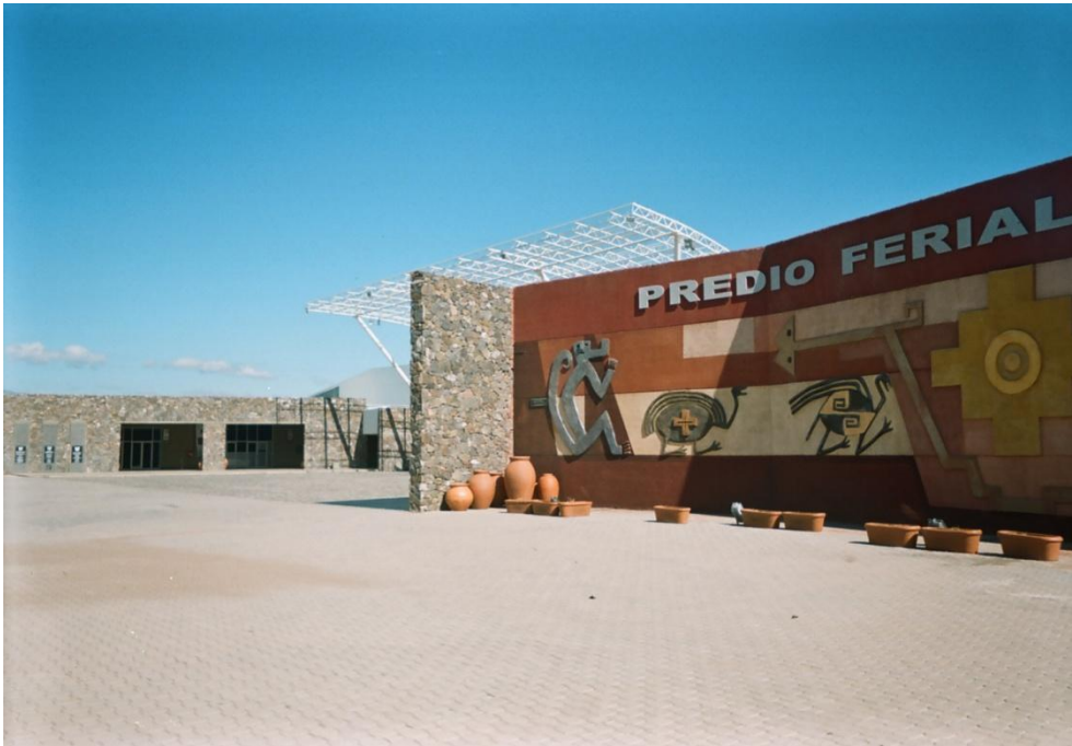
Foto N° 4. Mural de acceso en el Predio Ferial. Ciudad de San Fernando del Valle de Catamarca.
