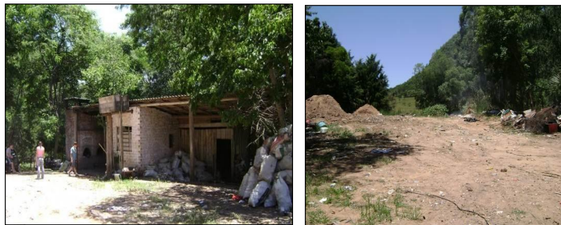
Figura 07- Instalações da Estação de Triagem e Aterro
