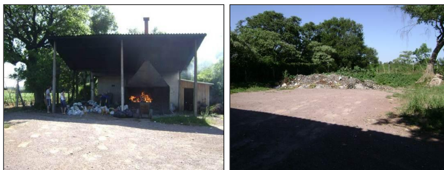
Figura 03- Instalações da Estação de Tratamento dos resíduos
