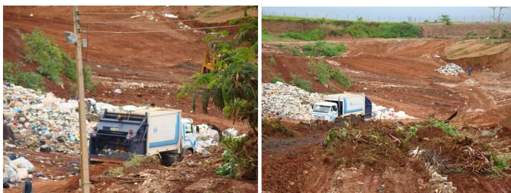
Fotos 6 e 7: Vista parcial do aterro controlado
