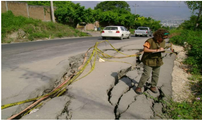
Foto 6. Grietas de tensión por desplazamiento. Carretera Tuxtla-Villaflores km 0.5. JP
