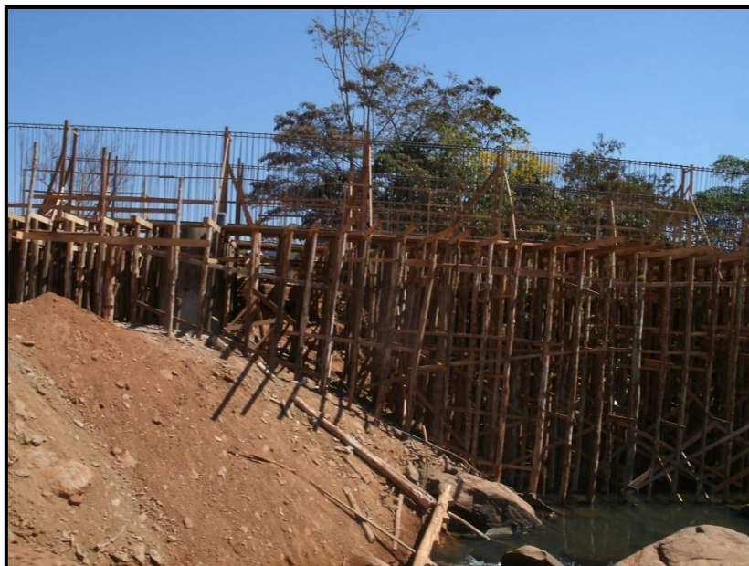
Fig.7: Construção da ponte sobre o Rio das Pedras, MT170. Fonte: ZOCHE, 2010.
