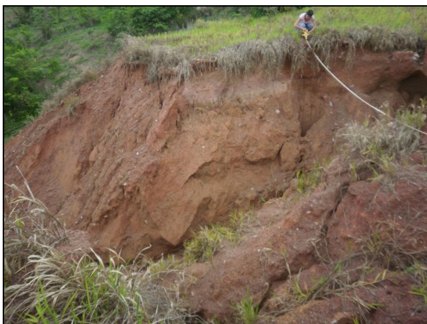
Fig.15: Dimensões atuais da ravina 3 no “capóia”. Fonte: FERREIRA, 2010.
