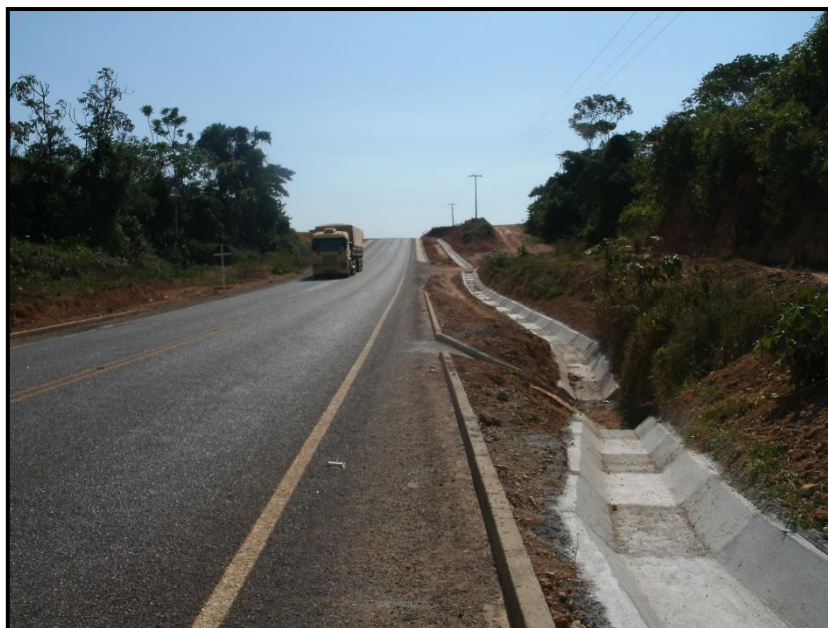
Fig.6: Sarjetas nas encostas da MT170. Fonte: ZOCHE, 2010.
