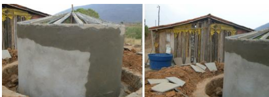
Figura 04 - Construção de cisternas.
