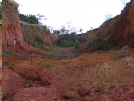
FOTO III: Vista atual da cabeceira da erosão, com mata de proteção nas surgências de água à montante e sedimentos ao longo do interior do vale, dentro da voçoroca. Foto: O. R. Megda – Julho -2010. (Erosão nº 30)
