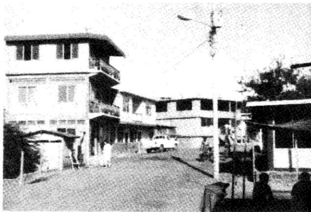
El auge constructivo en altura aparece en una calle central de puerto Ayora, en la isla Santa Cruz, en una clara imitación de formas arquitectónicas semejantes a cualquier ciudad del Ecuador continental. El número de viviendas pasó de 201 a 760 entre 1974 y 1982. Más de la mitad de ellas han sido construidas con bloques de cemento.
