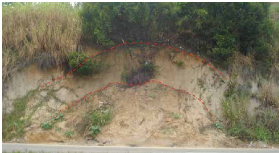
Figura 9. Cicatriz de ruptura circular em corte realizado em encostas da Com. Santa Clara
