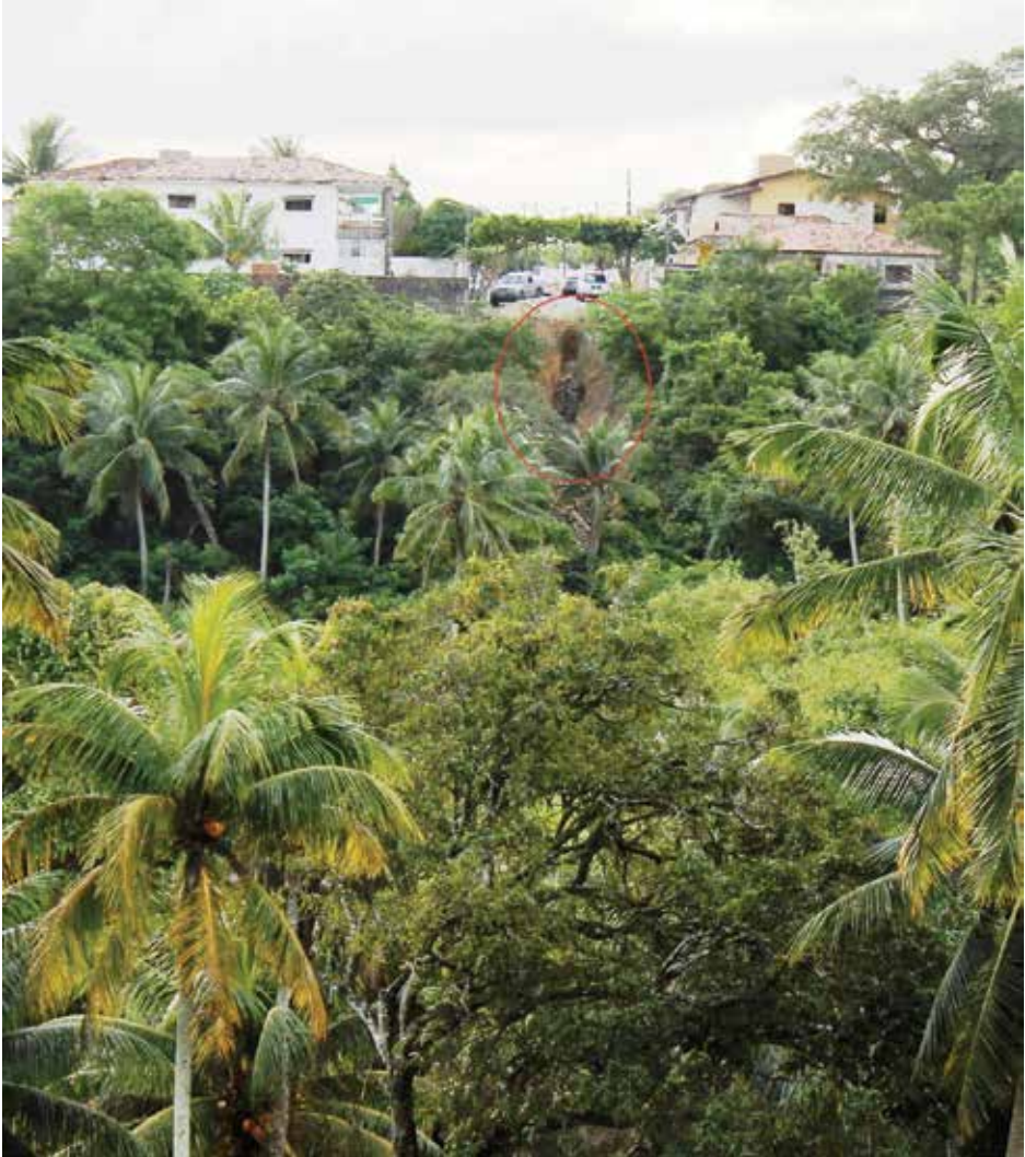
Figura 10. Ocorrência de processo erosivo em encosta do rio Jaguaribe, na rua Coronel Estevão D'ávila
