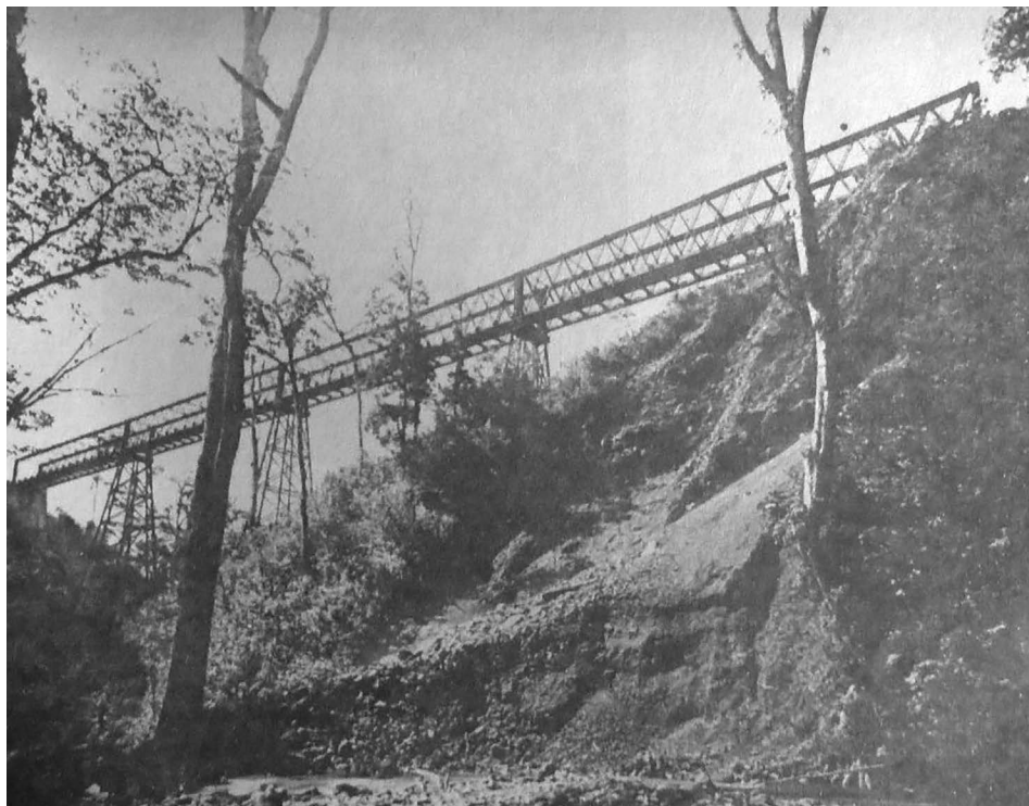
Figura 1. Puente ferroviario sobre río Birris
